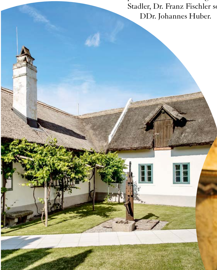
Foto – Innenhof Haydngeburtshaus Rohrau © Lukas Lorenz
